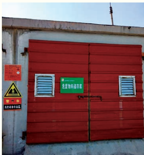
危废物料储存库
