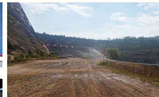
归来庄公司露天马道喷淋设施
