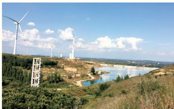
莱西公司北坝尾矿库
