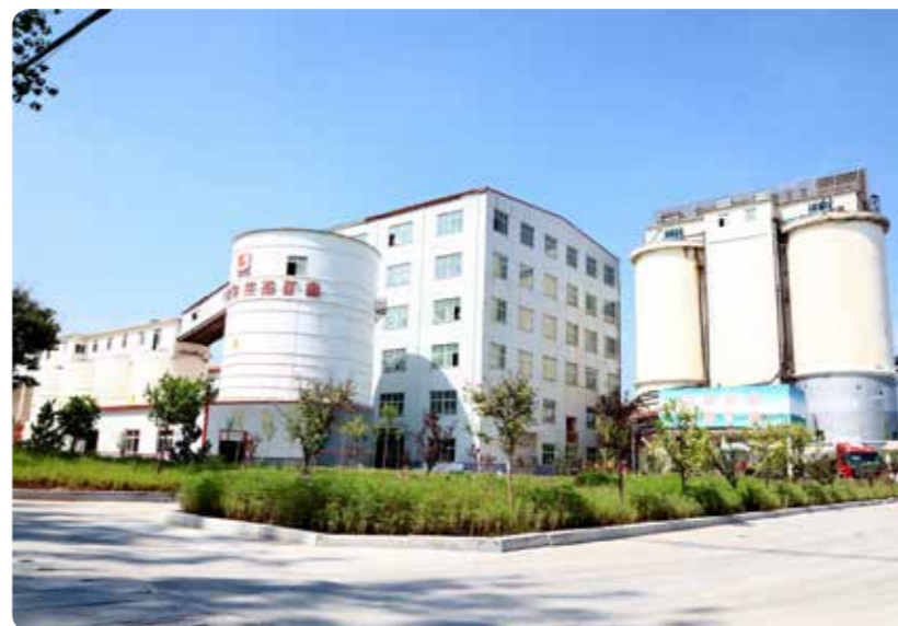
新城金矿厂区
