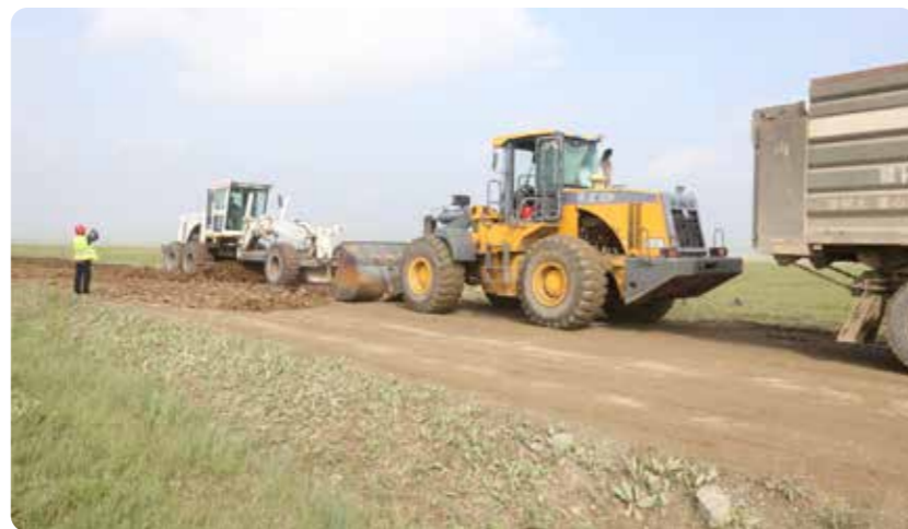
采用大型机械维护路面
