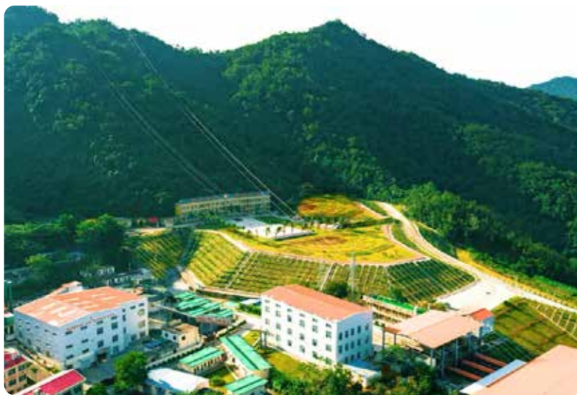
海南山金公司尾矿库
