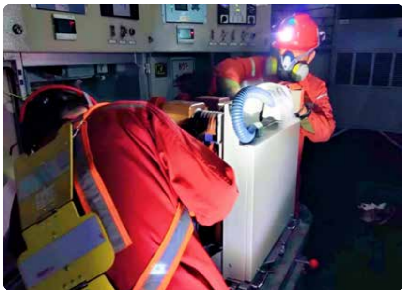
三山岛金矿员工检修设备
