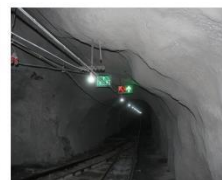
主溜井电动道岔
