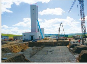
2018年5月18日充填站工程开工建设。图为充填站基础浇筑
