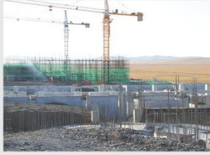
2017年10月22日2000t/d选厂厂房基础工程全面完工，从无到有，到基础完成，历时仅69天，摄于2017年10月27日
