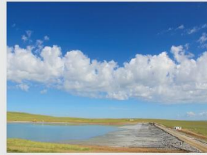
2018年10月28日尾矿库建设完成
