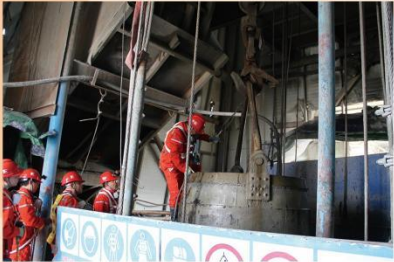
2017年10月28日主井至风井300m中段脉外巷精准贯通，贯通距离1435m，图为工作人员乘坐吊桶有序下井
