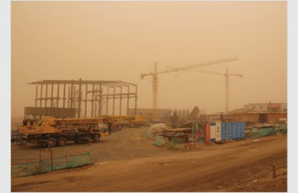
2018特大沙尘暴后的地表施工现场，白音呼布人的心中总是有一种“狂风暴雨终会被褐色风暴压倒”的执着与坚定
