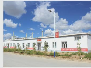
2018年9月3日化验室及选厂办公室建设完成，同时投入使用
