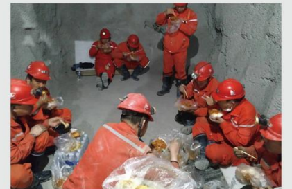
2019年8月15日公司青年员工井下维修充填管，清理淤泥，图为井下用餐
