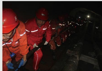
2019年7月19日公司全体青年职工井下下放电缆，作为“青春白音呼布”团队的中坚力量，作为白音呼布发展的中流砥柱，他们一直奋战在公司发展的最前线
