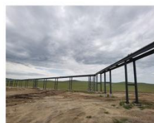
尾矿输送及回水管路
