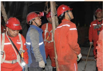
2018年2月11日春节期间井下风门搭建施工现场
