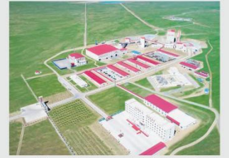
2020年底，锡林郭勒盟山金白音呼布业有限公司花脑特银多金属矿完成项目建设，同时进入国家绿色矿山名录，图为公司鸟瞰图
