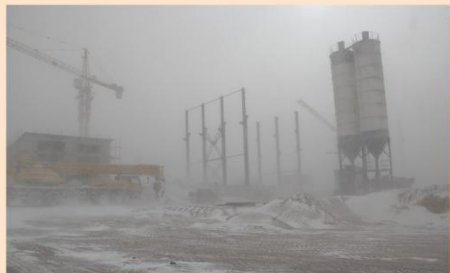
2018年4月3日白毛风肆虐的地表工程施工现场，气温降到-35℃，图为恶劣气候中屹立的白音呼布
