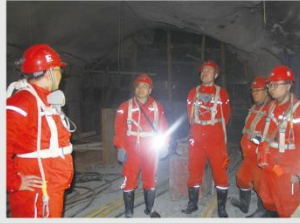
2018年4月23日风井350m中段与主井顺利贯通，井下通风系统形成，图为350m中段主井筒风门处施工现场
