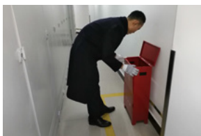
定期检查消防设施
