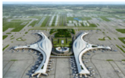
参与成都天府国际机场脚手架工程
