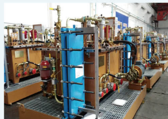
通用武汉冲压线项目
