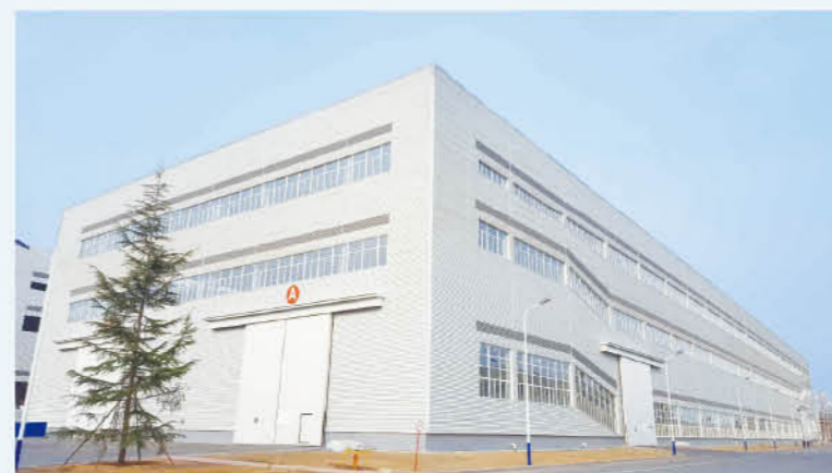
济南重工隧道建设装备有限公司盾构机厂房配电
