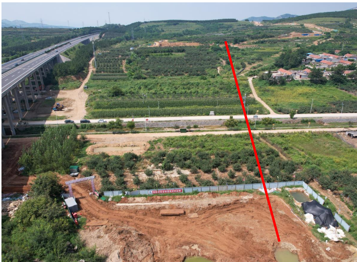
图 3.2-7 下炉河穿越处地形地貌
