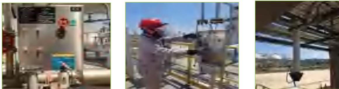
图 2.2-6 密闭采样器密闭采样装车密封
