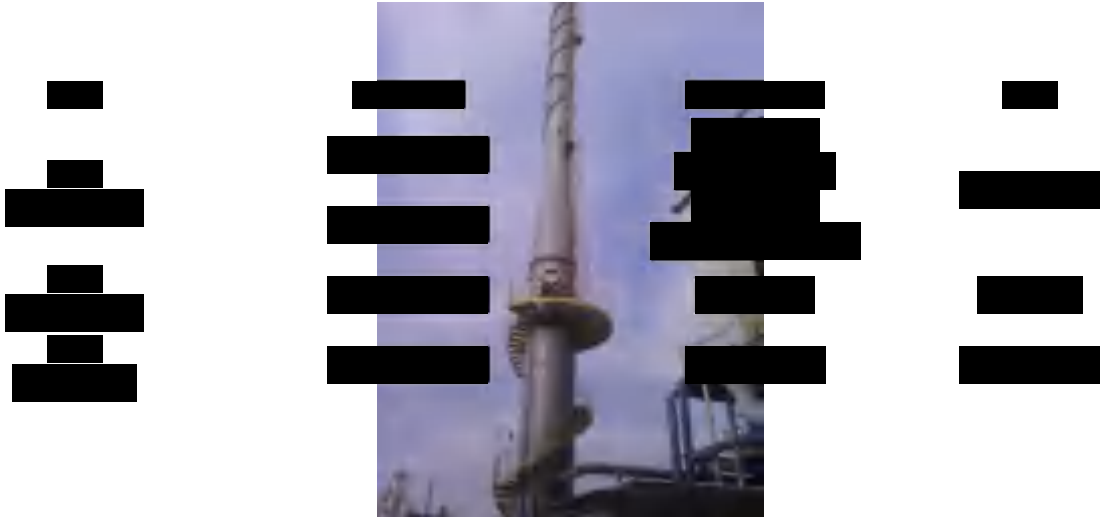
图 2.2-3 1#MMA 废水焚烧炉外貌图
