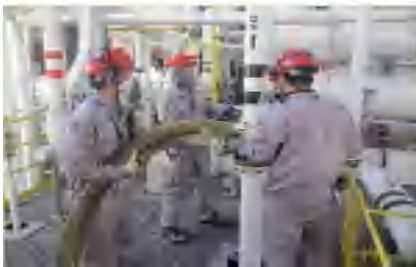
图 2.2-5 检修时废气软管收集设施
