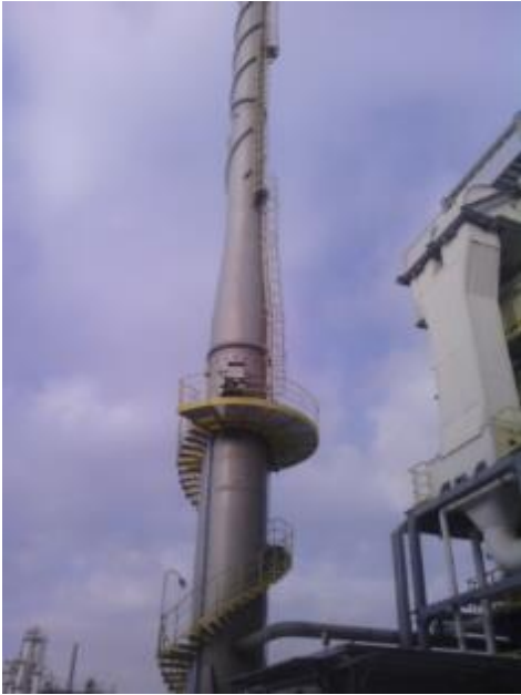
图 2.2-3 1#MMA 废水焚烧炉外貌图
