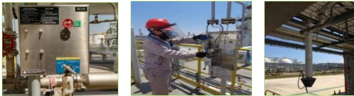
图 2.2-6 密闭采样器密闭采样装车密封
