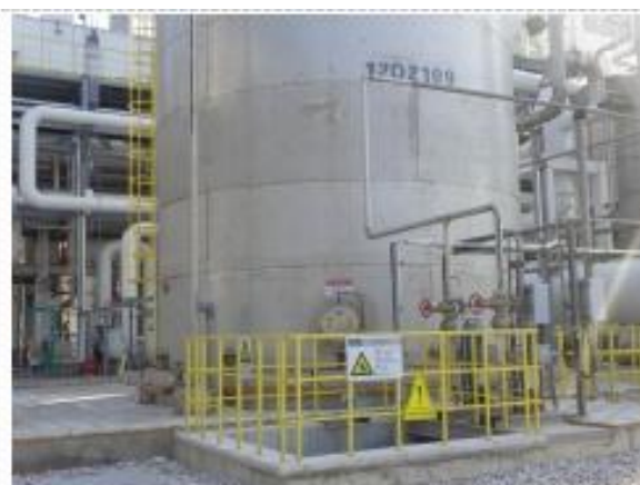
装置区围堰及污水收集池
