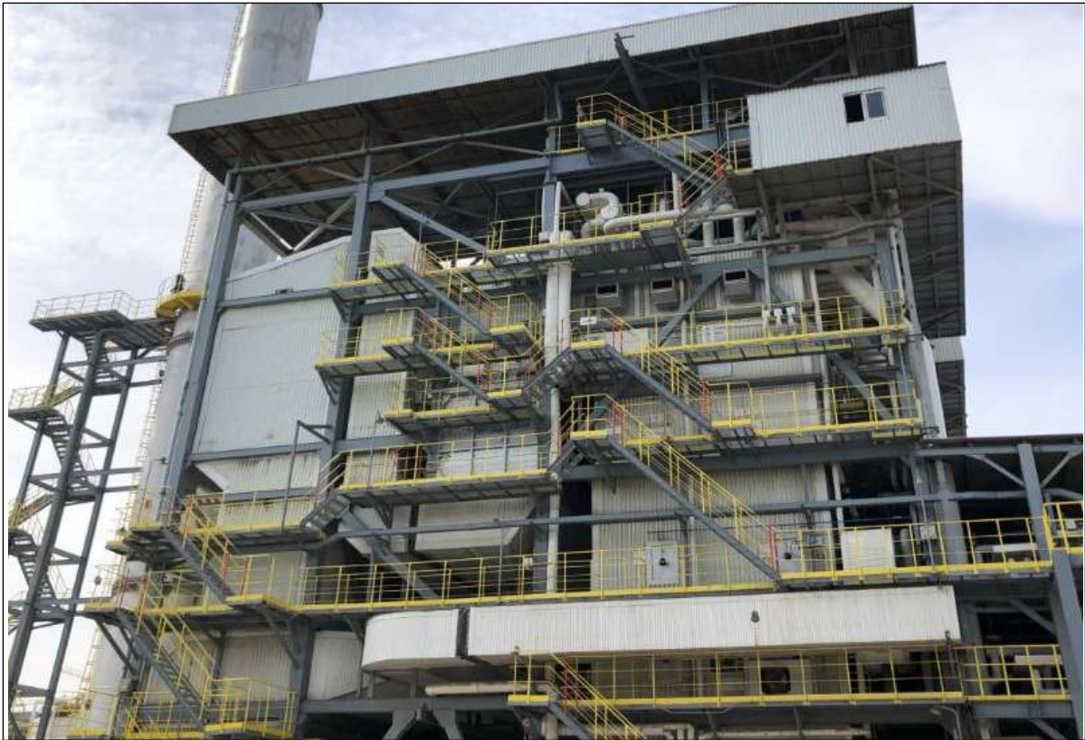
图 2.2-2 废能锅炉外貌图
