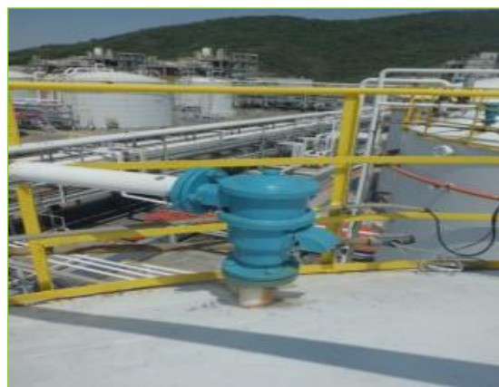
图 2.2-4 储罐安全阀排气收集
