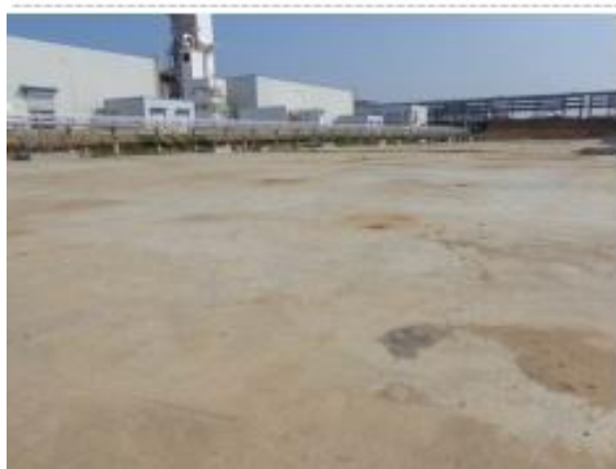
全厂初期雨水池
