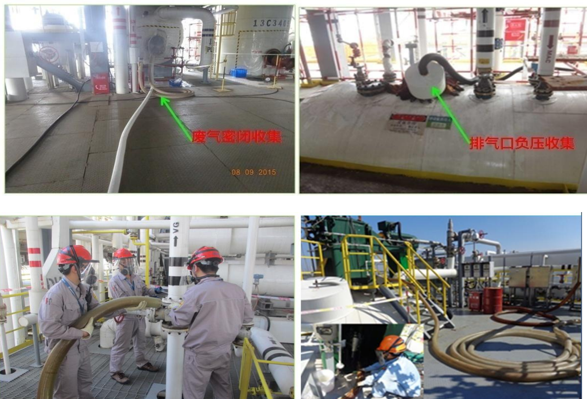
图 2.2-5 检修时废气软管收集设施
