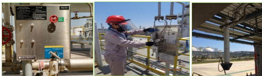
图 2.2-6 密闭采样器密闭采样装车密封
