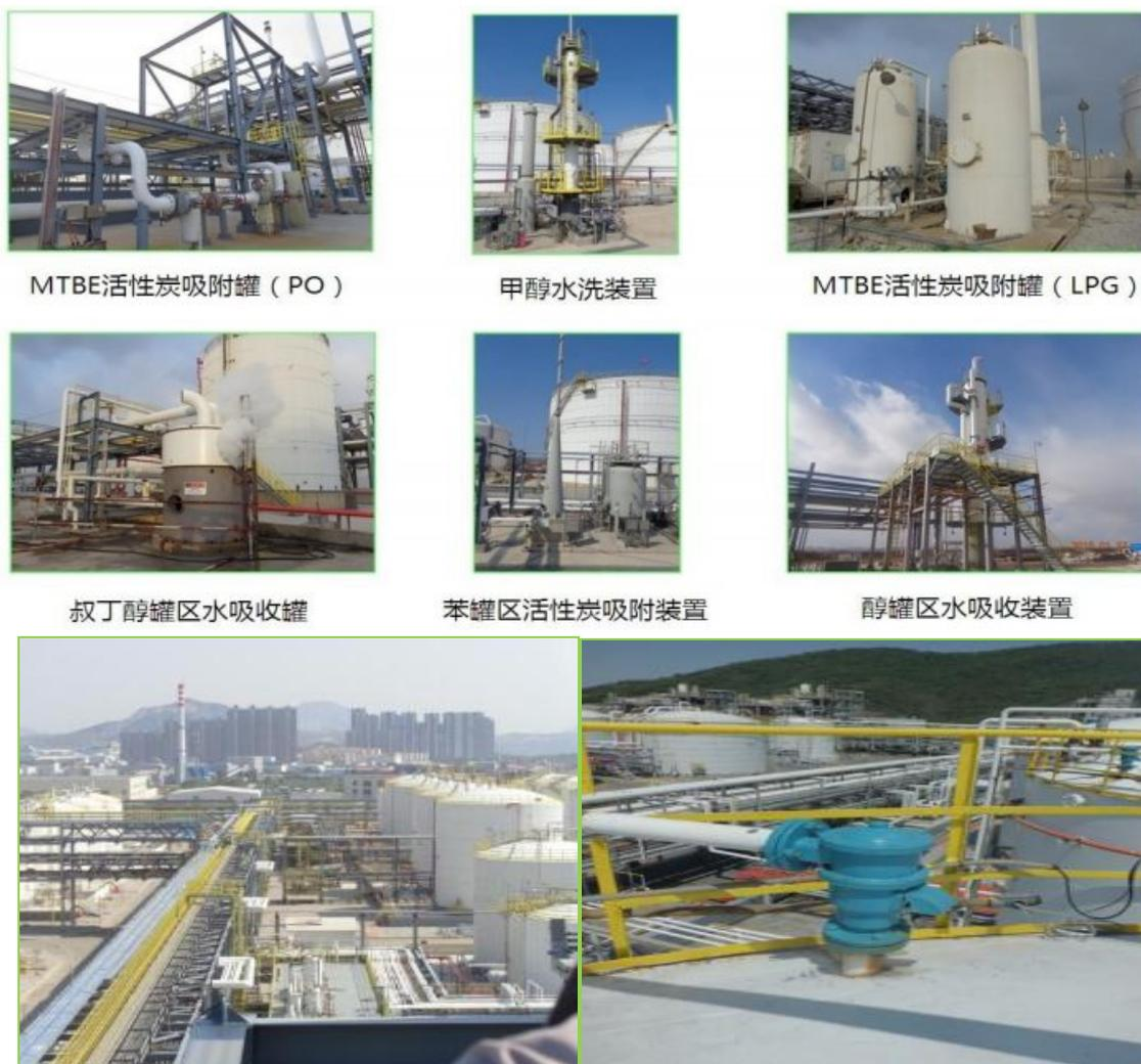
图 3-4 储罐安全阀排气收集
