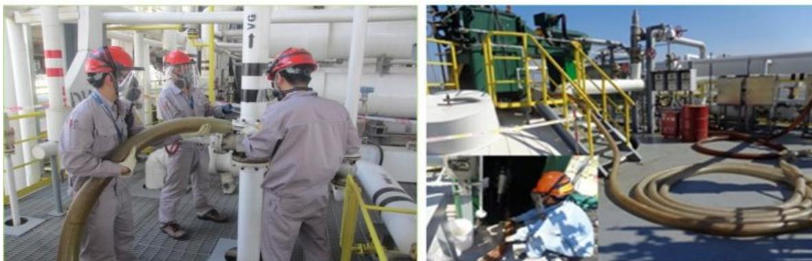
图 3-5 检修时废气软管收集设施
