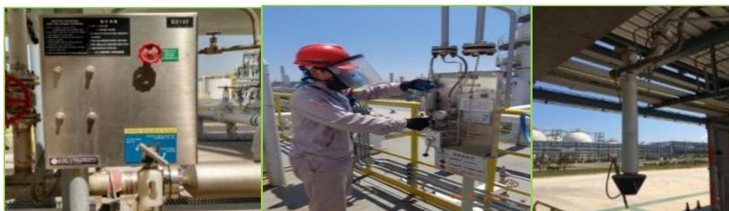
图 3-6 密闭采样器密闭采样装车密封
