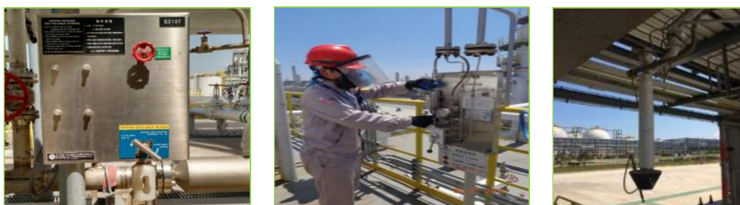
图 3.2-3 密闭采样器密闭采样装车密封
