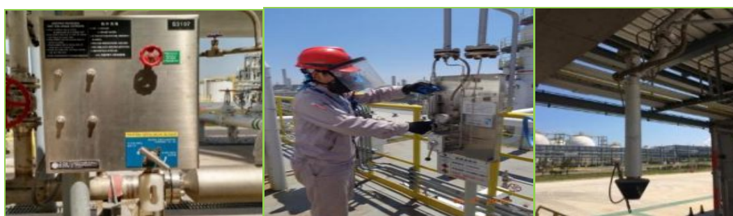
图 3.2-3 密闭采样器密闭采样装车密封
