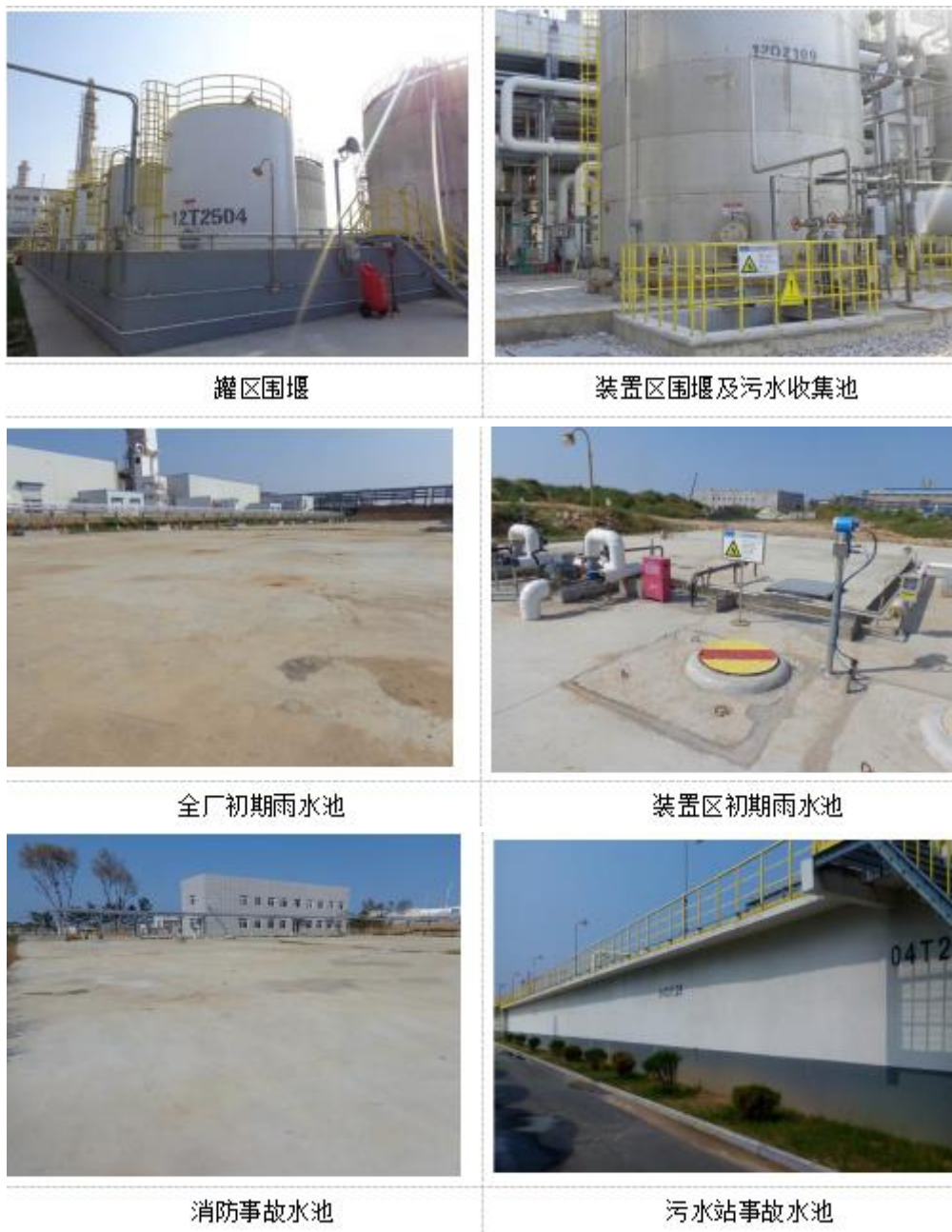
图 7.1-2 现有工程水环境风险防范设施
