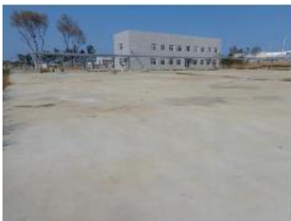
消防事故水池
