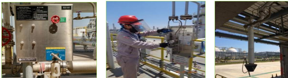
图 2.2-6 密闭采样器密闭采样装车密封
