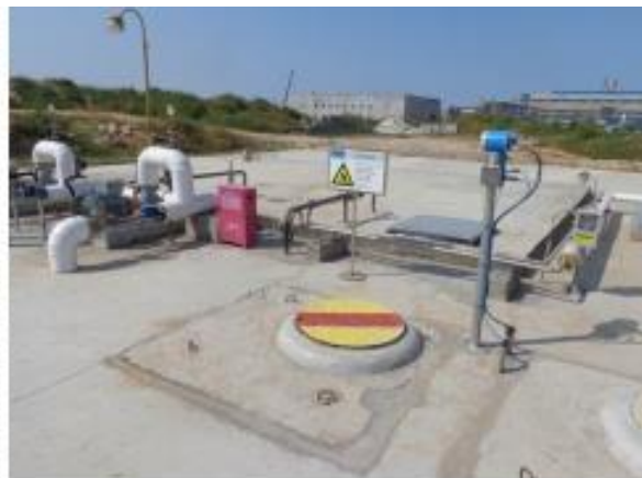
装置区初期雨水池
