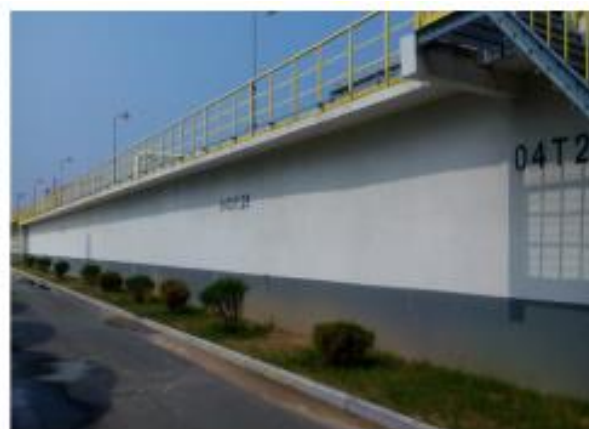
污水站事故水池
