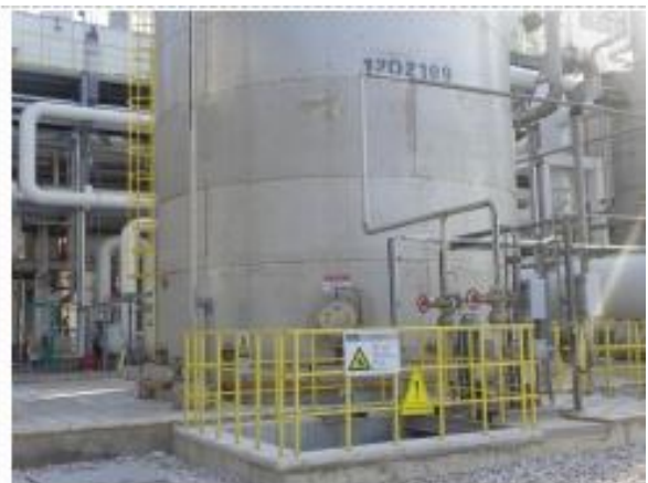
装置区围堰及污水收集池
