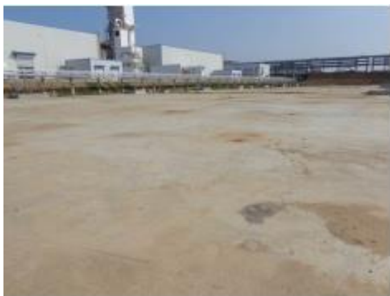
全厂初期雨水池
