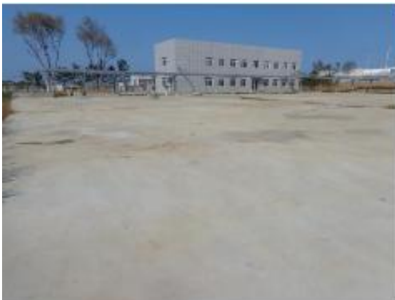
消防事故水池
