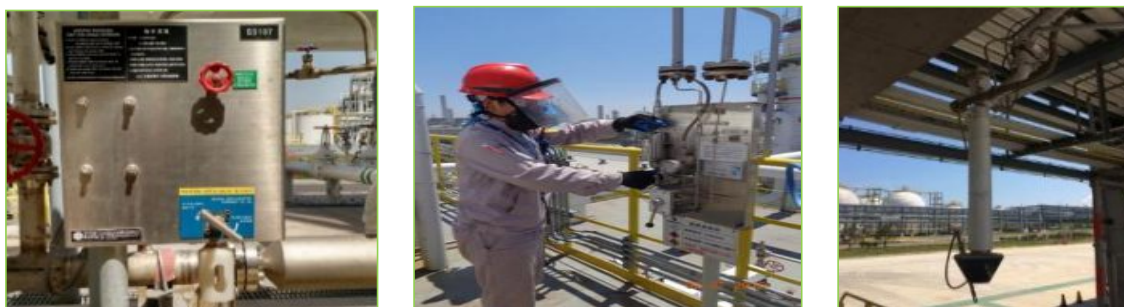
图 2.2-6 密闭采样器密闭采样装车密封
