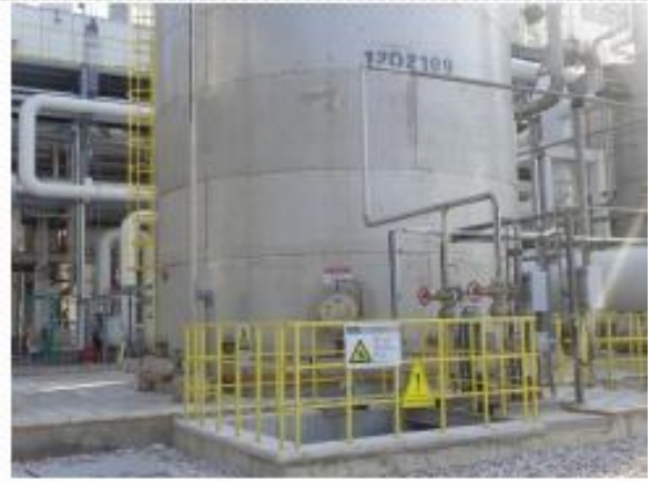
装置区围堰及污水收集池
