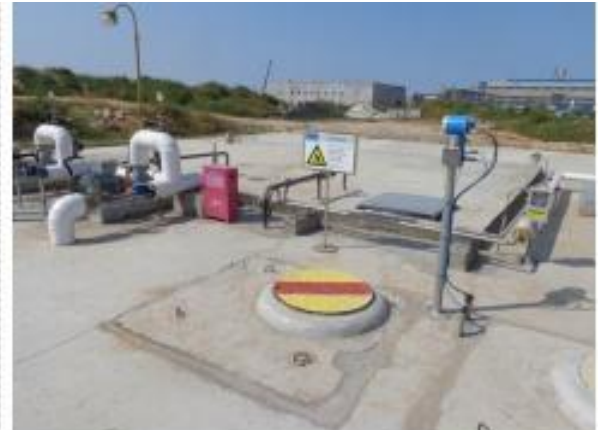
装置区初期雨水池
