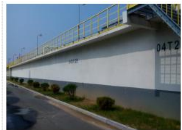
污水站事故水池
