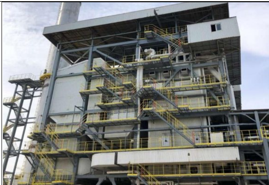
图 2.2-2 废能锅炉外貌图
