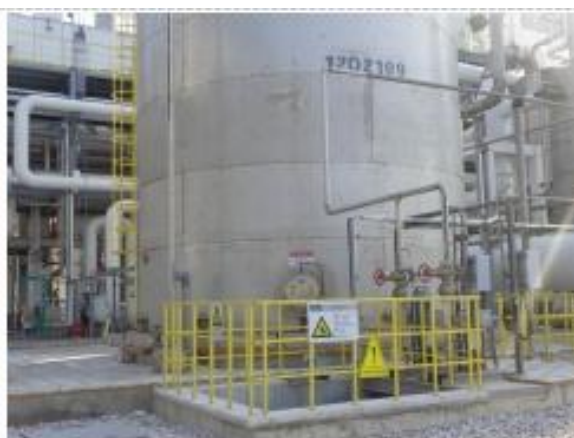
装置区围堰及污水收集池
