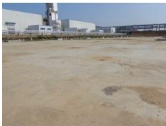
全厂初期雨水池
