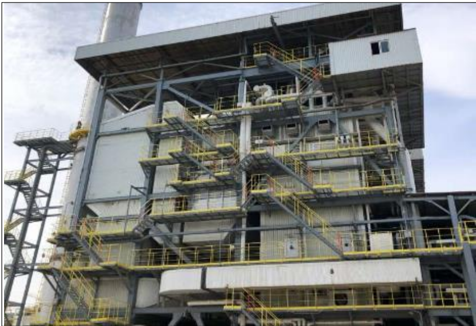
图 2.2-2 废能锅炉外貌图 表 2.2-11 废能锅炉处理情况表
