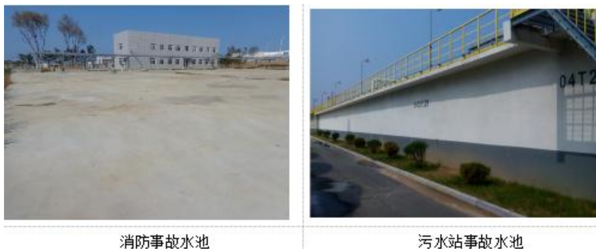
图 7.2-2 现有工程水环境风险防范措施
