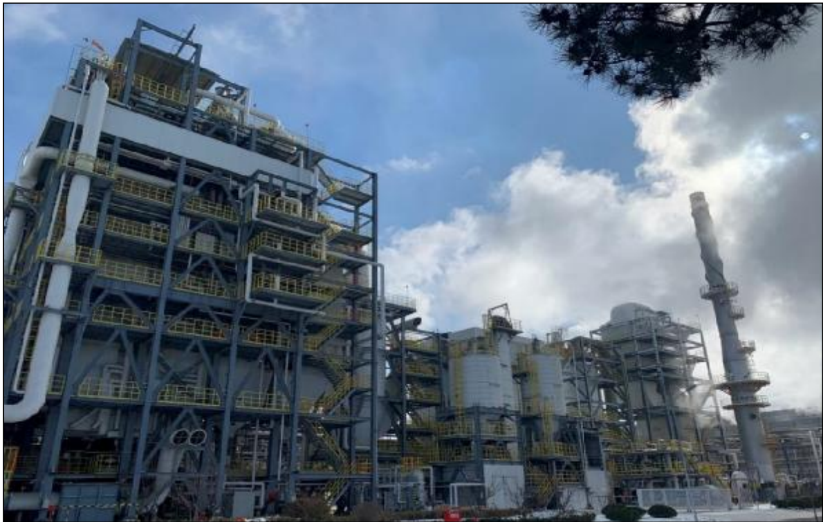
图 2.2-1 TDI 能量回收炉外貌图 TDI 能量回收炉现有处理情况见表 2.2-10。
