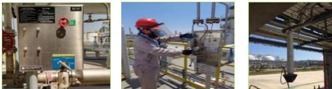
图 2.2-6 密闭采样器密闭采样装车密封
