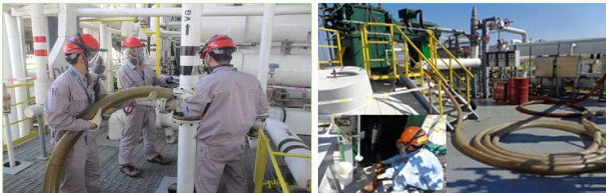
图 3.2-4 检修时废气软管收集设施
