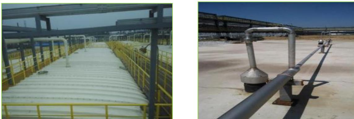
图 3.2-6 污水处理系统、污水池废气收集设施
