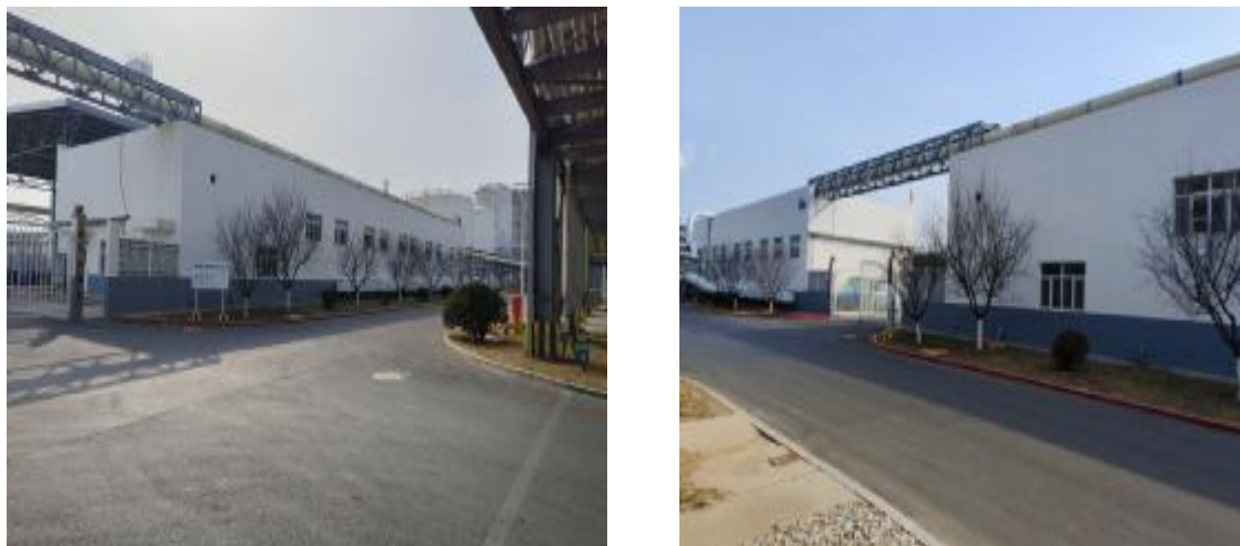
图 10.2-4 拟建项目依托固废站现状图
