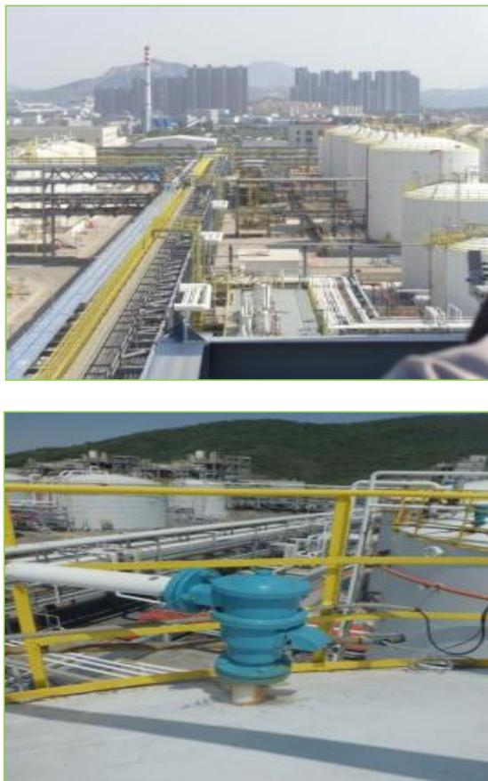
图 2.2-4 储罐安全阀排气收集
