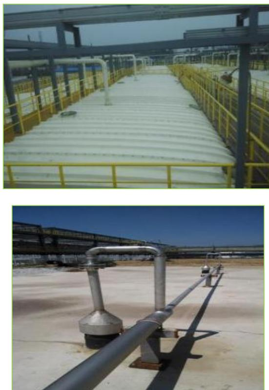
图 2.2-7 污水处理系统、污水池废气收集设施
