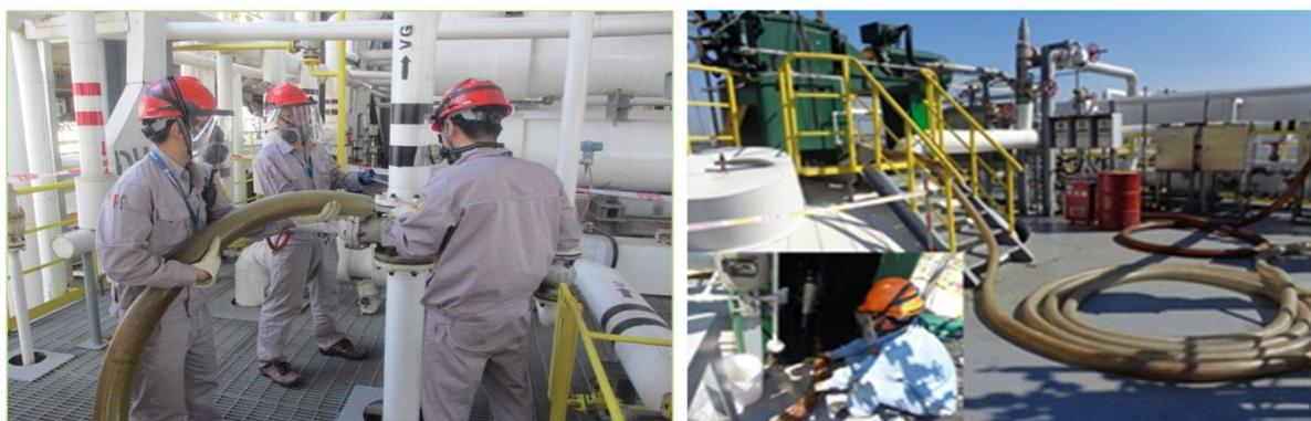
图 2.2-5 检修时废气软管收集设施
