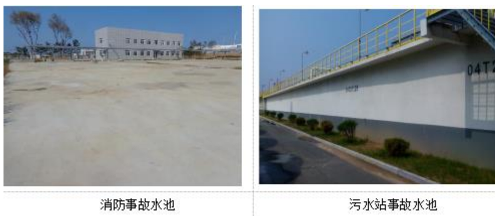
图 7-2 现有工程水环境风险防范设施
