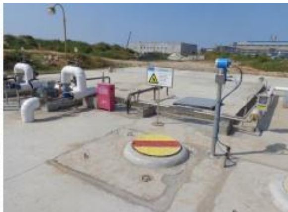
装置区初期雨水池
