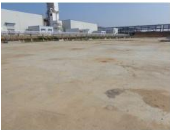
全厂初期雨水池
