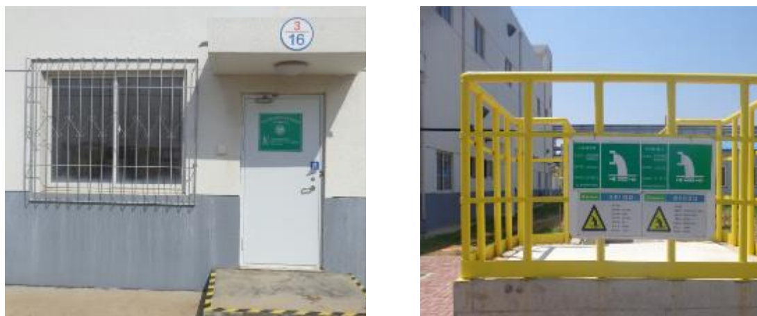
图 15.3-2 现有排污口及在线监测小屋
