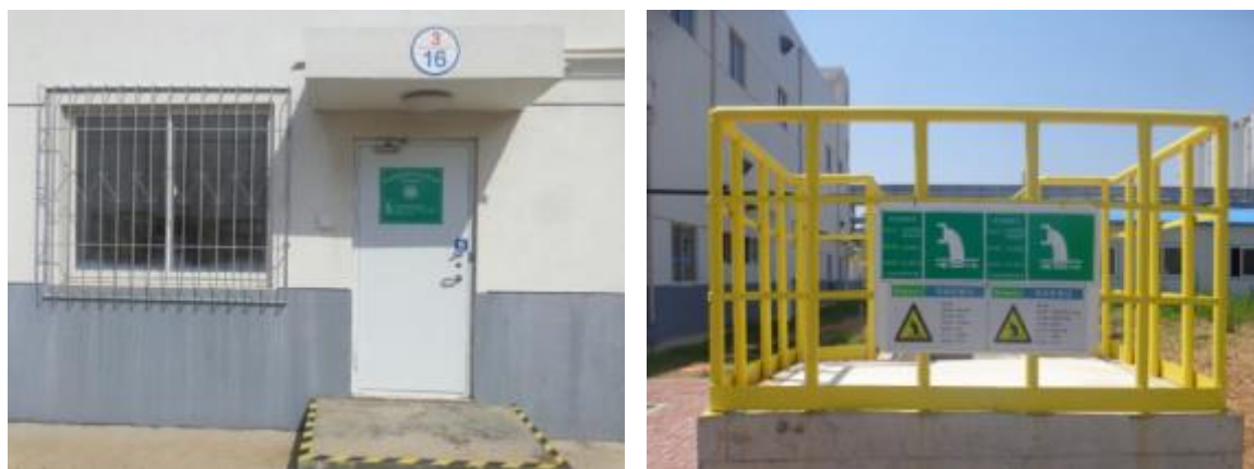
图 2.4-1 万华现有排污口及在线监测小屋
