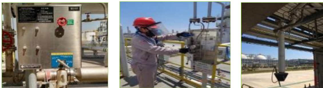
图 2.2-6 密闭采样器密闭采样装车密封
