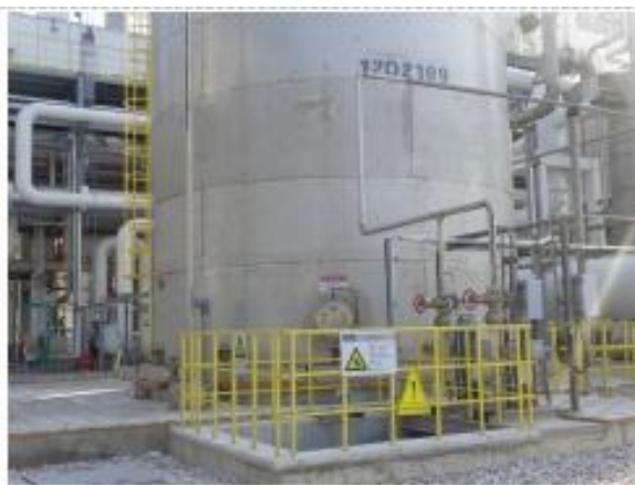
装置区围堰及污水收集池
