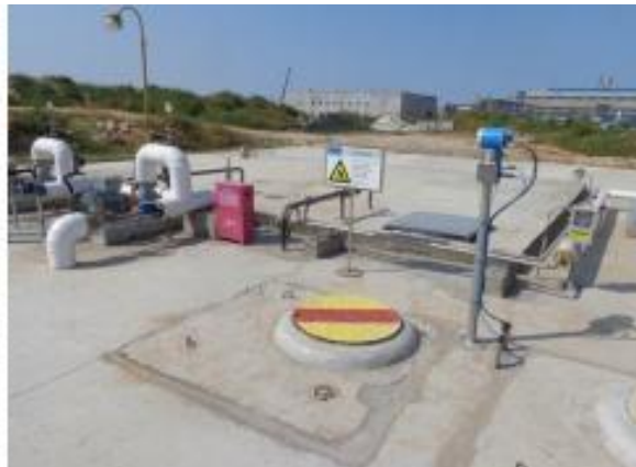
装置区初期雨水池
