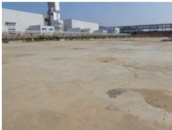
全厂初期雨水池
