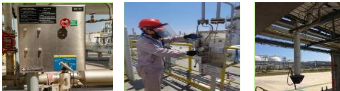
图 2.2-6 密闭采样器密闭采样装车密封
