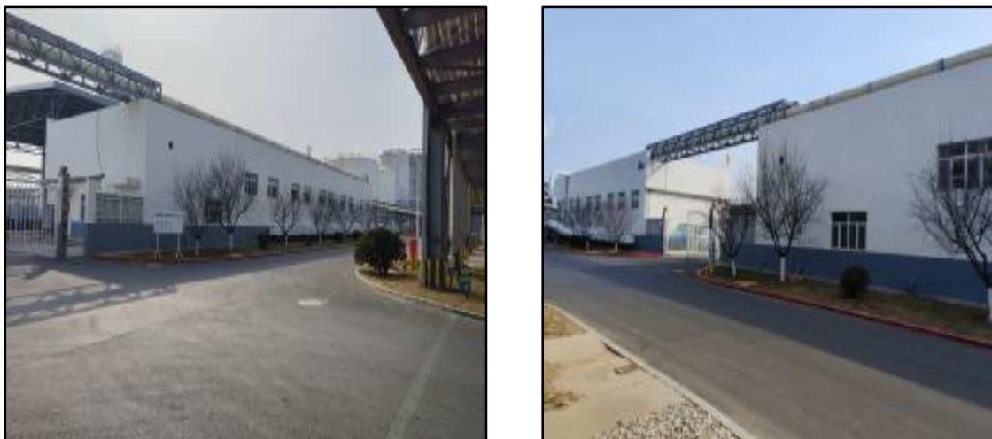
图 3.9-3 拟建项目依托固废站现状图
