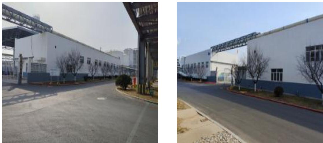
图 6.5-2 拟建项目依托固废站现状图
