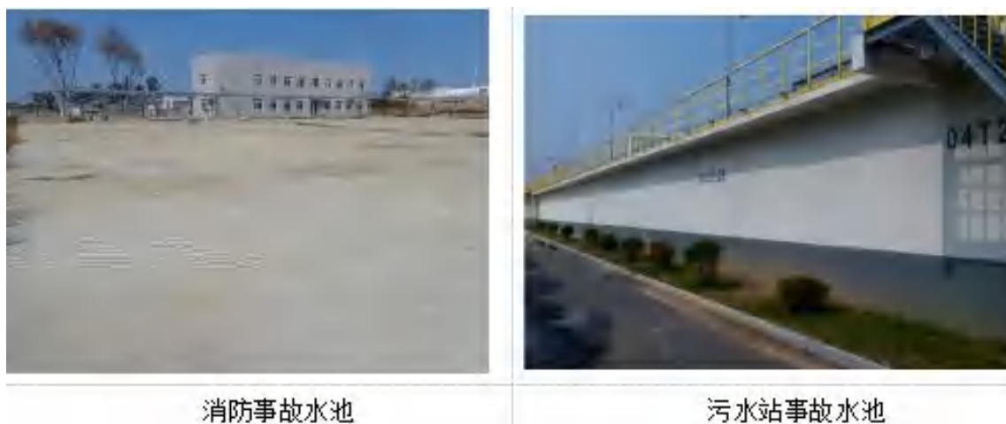
图 7.1-1 现有工程水环境风险防范设施
