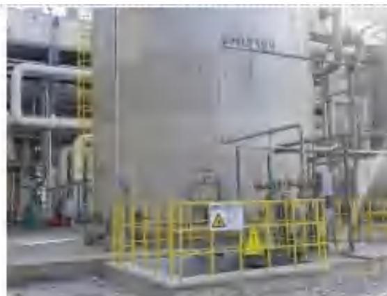
装置区围堰及污水收集池
