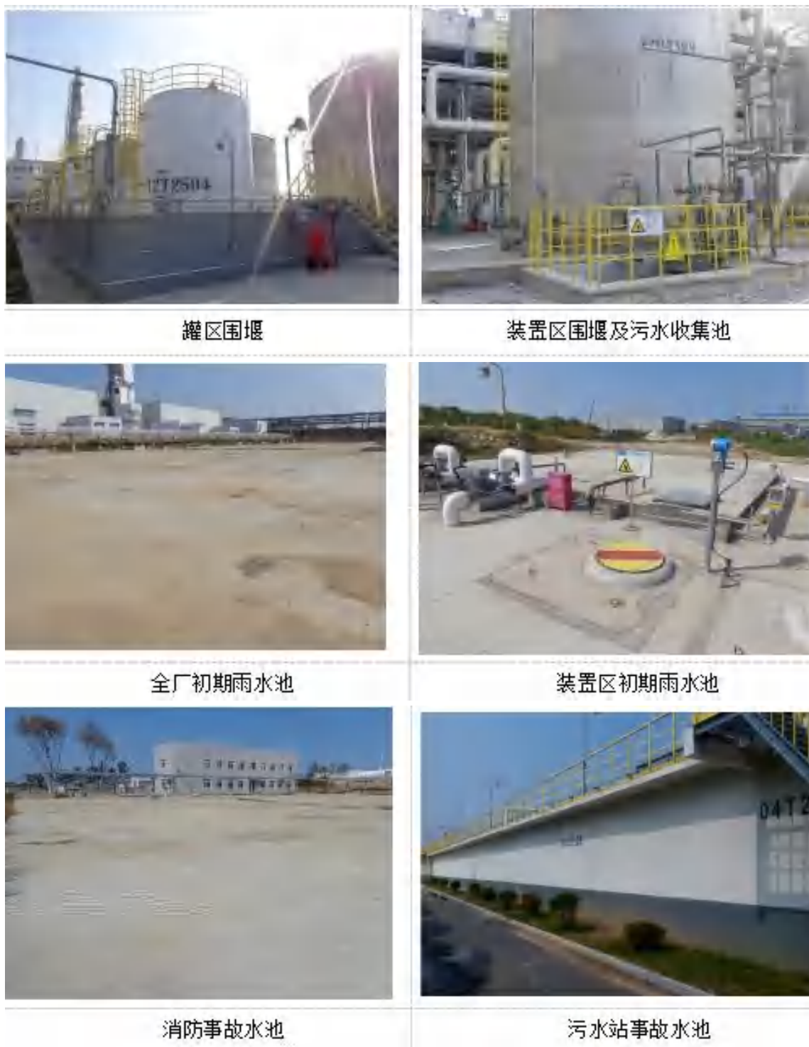
图 7.1-1 现有工程水环境风险防范设施
