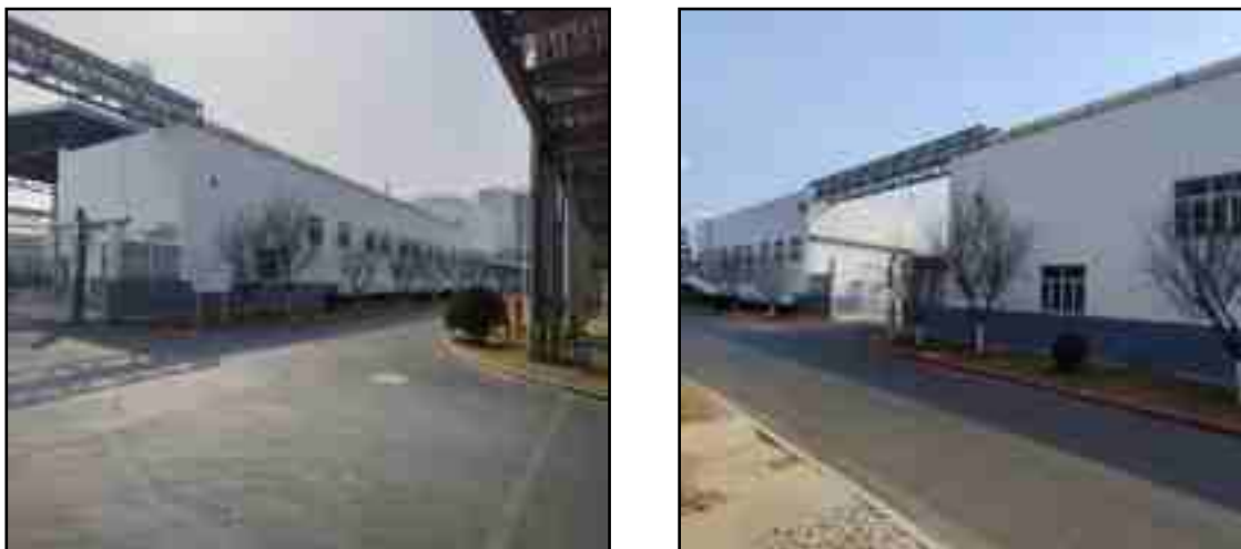
图 3.3-8 拟建项目依托固废站现状图
