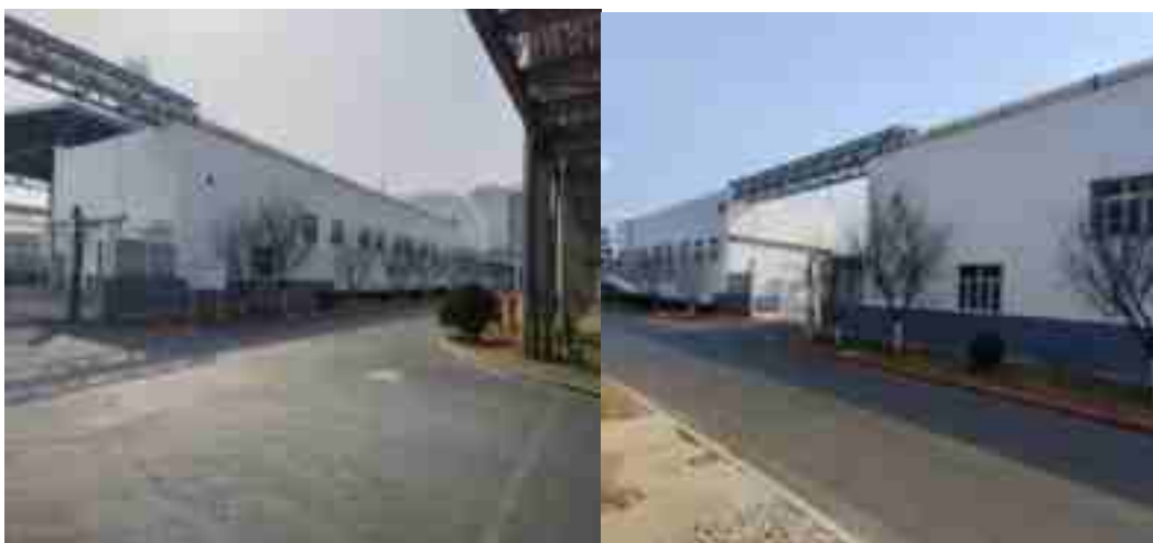
图 10.2-3 拟建项目依托固废站现状图
