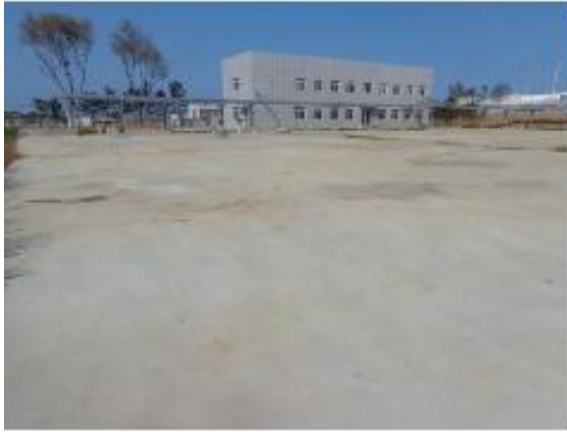
消防事故水池
