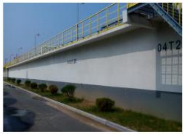
污水站事故水池
