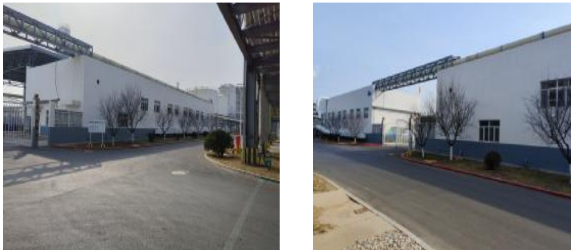
图 10.2-3 拟建项目依托固废站现状图
