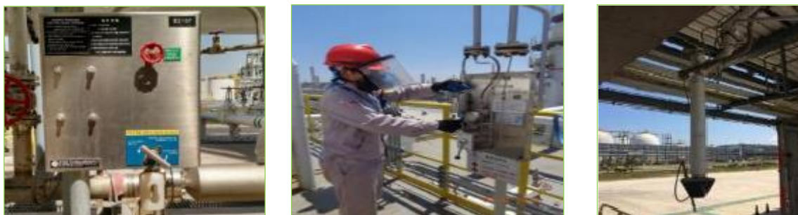
图 2.2-6 密闭采样器密闭采样装车密封
