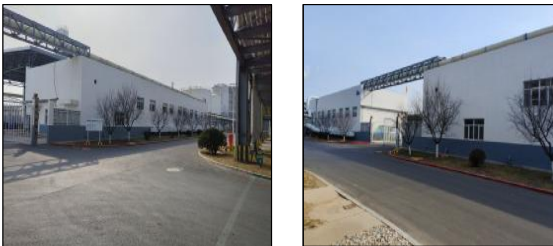
图 3.9-2 拟建项目依托固废站现状图
