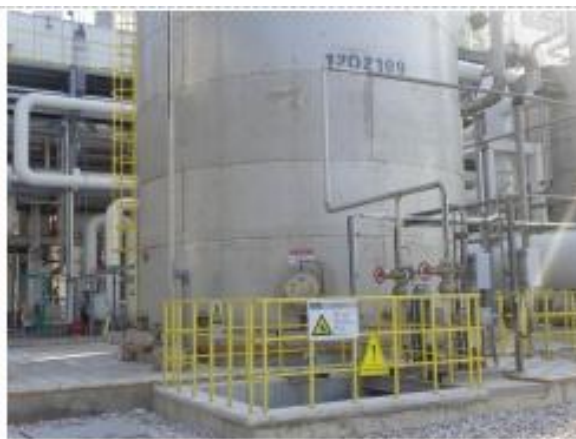
装置区围堰及污水收集池
