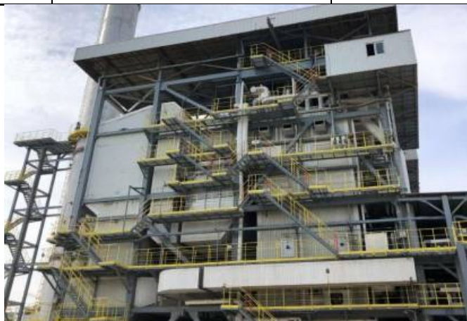
图 3.2-2 废能锅炉外貌图
