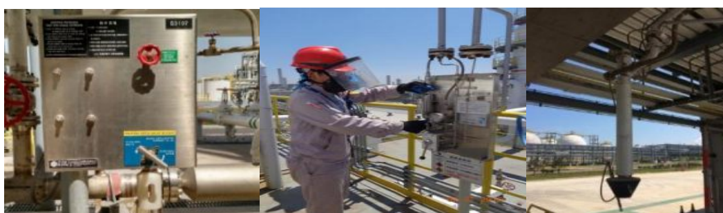
图 3-7 密闭采样器密闭采样装车密封
