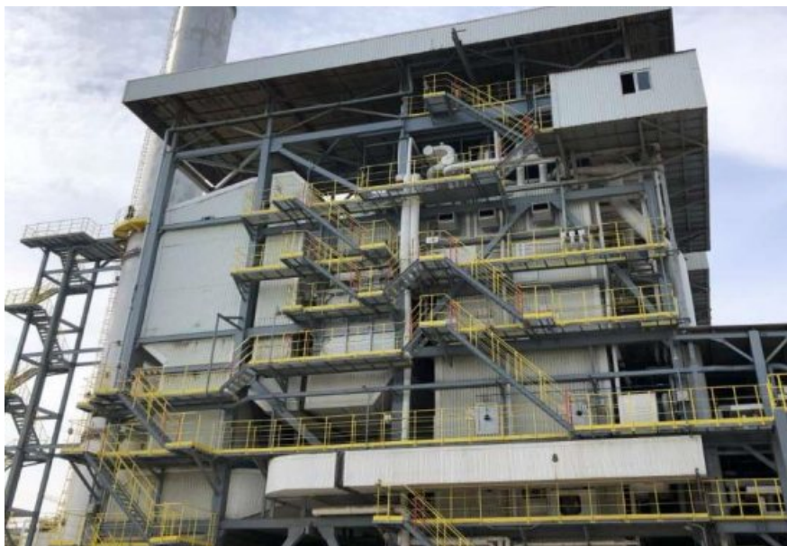
图 3-4 废能锅炉外貌图
