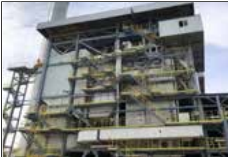
图 2.2-2 废能锅炉外貌图
