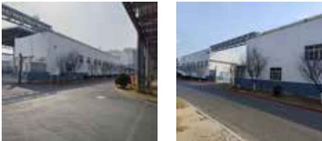
图 9.2-3 拟建项目依托固废站现状图
