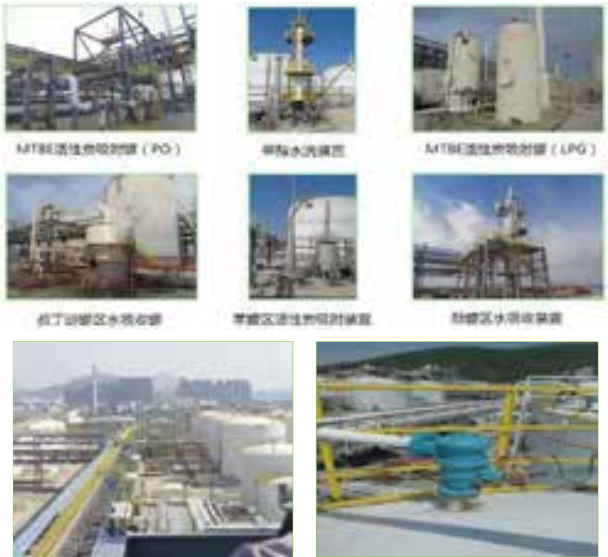
图 2.2-4 储罐安全阀排气收集
