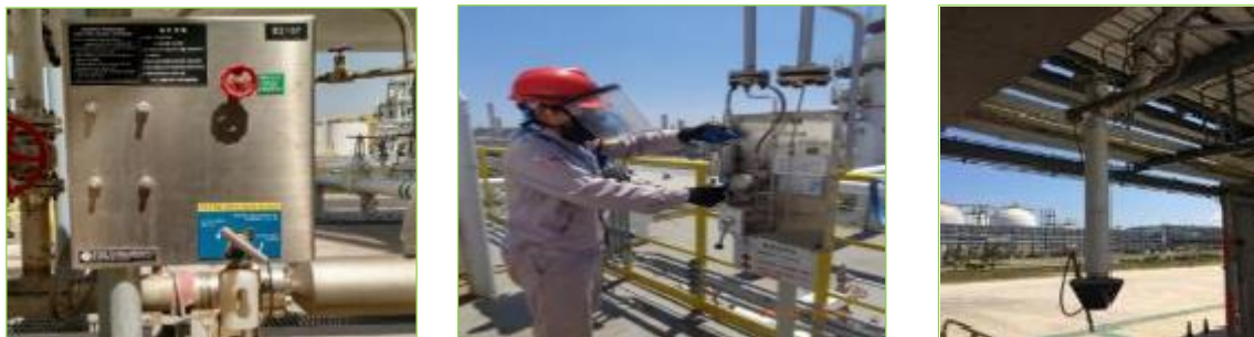
图 2.2-6 密闭采样器密闭采样装车密封
