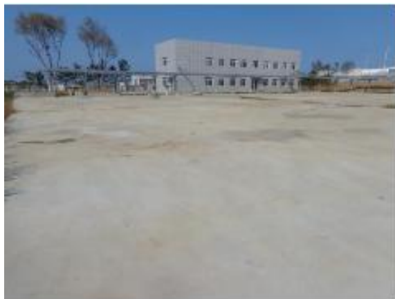
消防事故水池
