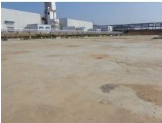
全厂初期雨水池
