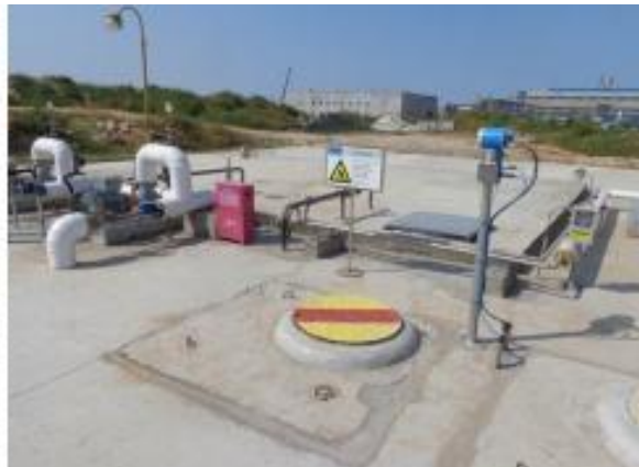
装置区初期雨水池
