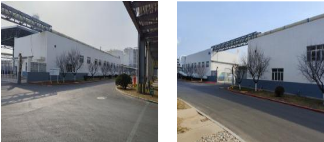
图 10.2-9 拟建项目依托固废站现状图
