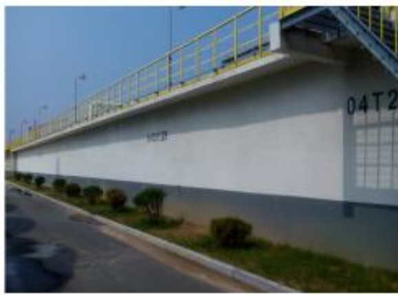
污水站事故水池
