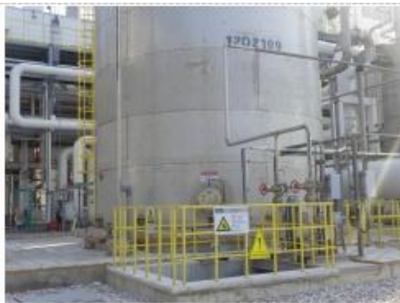
装置区围堰及污水收集池
