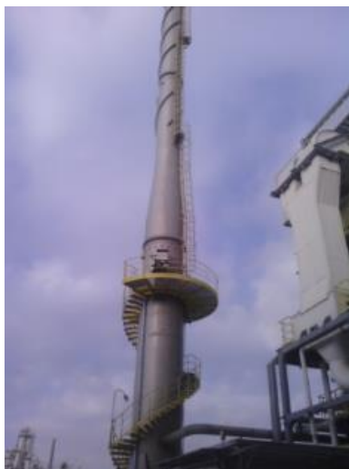
图 2.2-3 1#MMA 废水焚烧炉外貌图
