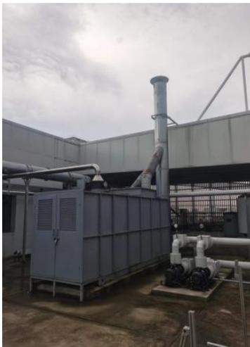
图 4 挤塑 VOCs 废气处理设施
