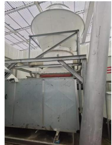
图 6 实验室废气处理设施
