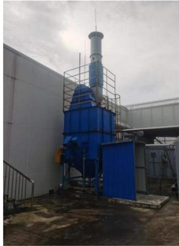
图 2 挤塑废气除尘处理设施
