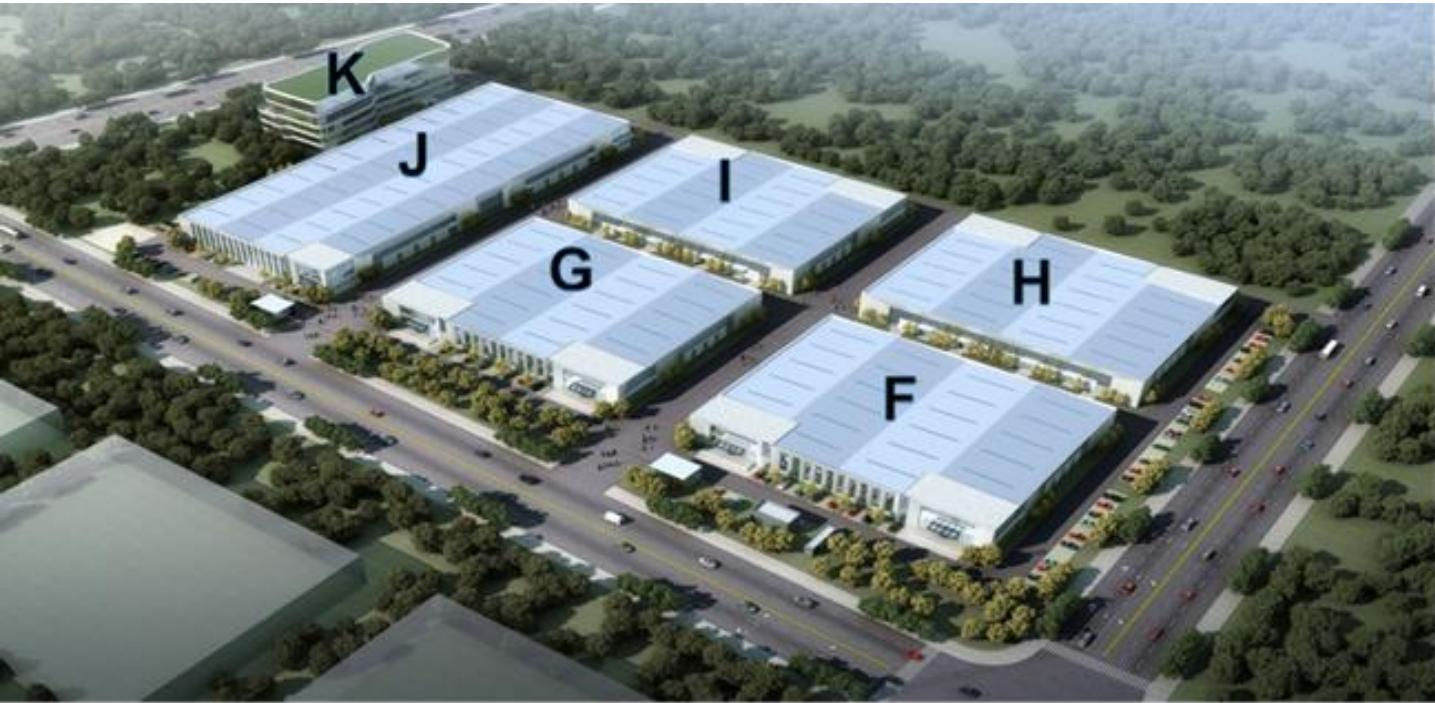
二期项目总占地85881.8m<sup>2</sup>（约113.9亩），建筑面积53467.54m<sup>2</sup>，规划建设5栋单层钢结构标准厂房，1栋多层厂房及配套用房。
