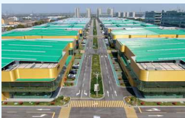
行车主干道 Roadway
