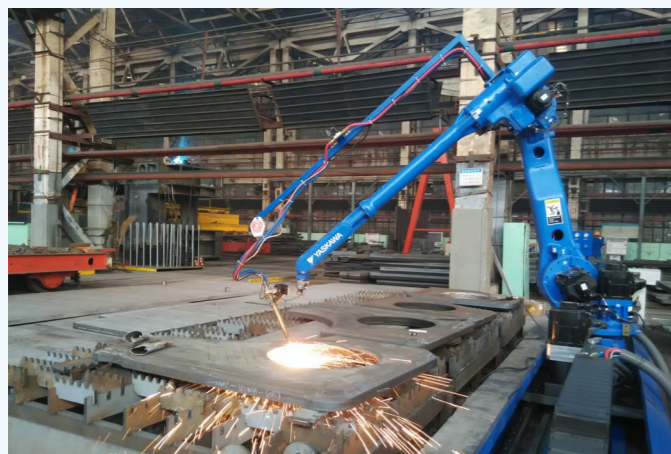
机器人火焰切割 Robot flame cutting
