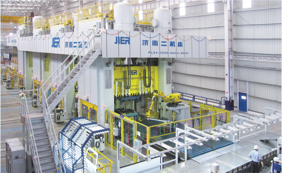
机器人冲压生产线
