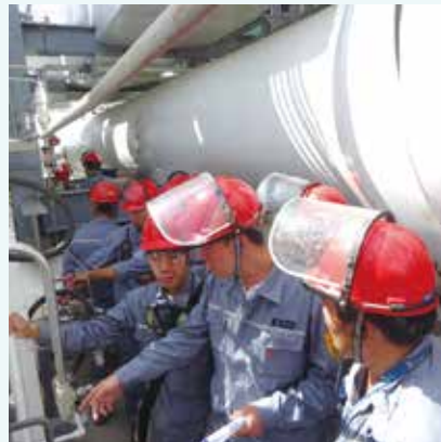
新材料聚酯多元醇装置二期 7 条生产线顺利投产，脱硝系统一次性调试成功
