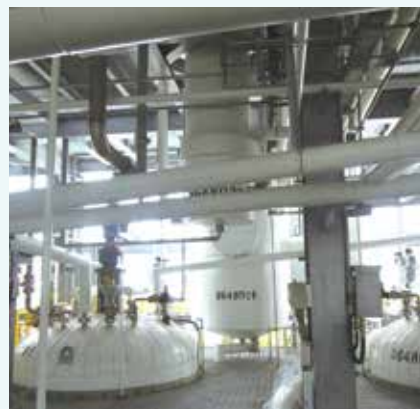
宁波连续化 VOC 脱除装置一次开车成功
